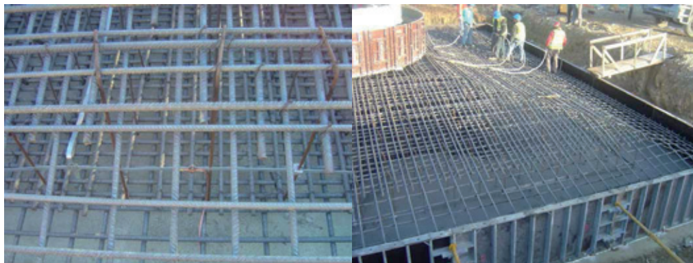
Rysunek 13: System uziemienia elektrowni wiatrowej
