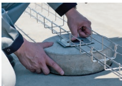
Przyłożenie adaptera TrayFix wraz z płytką, dociśnięcie, gotowe
