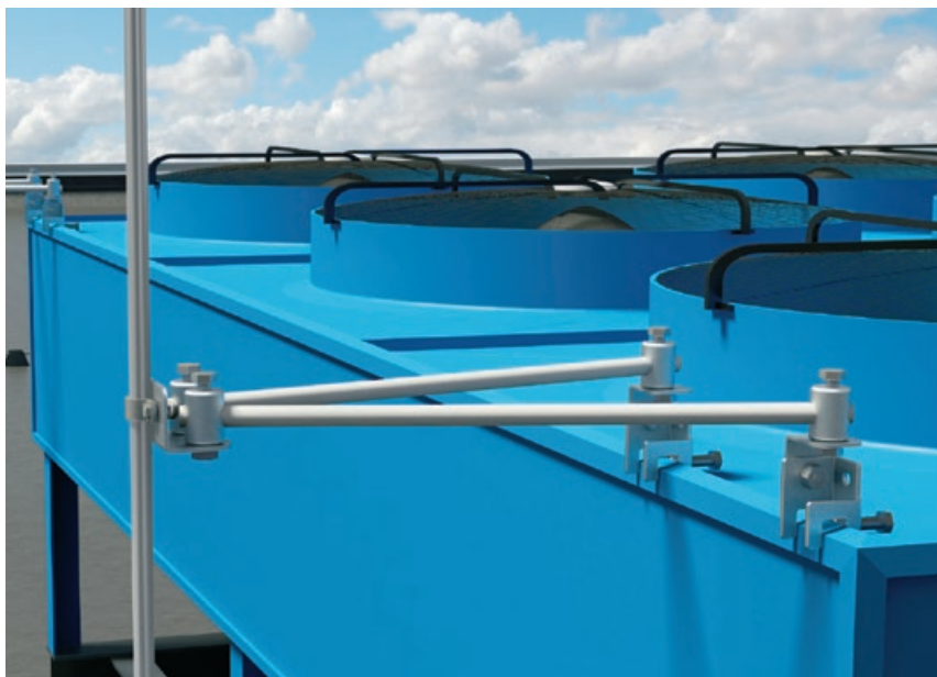
Izolowana ochrona odgromowa z wykorzystaniem uchwytów z włókna szklanego podpiętych do klimatyzatora
