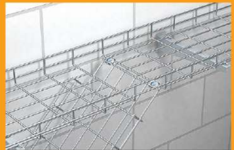
Wykonanie odejścia, użyj złączki GSV 34.
