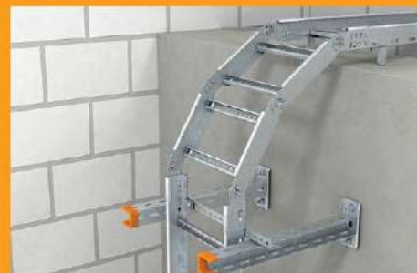
Montaż drabiny kablowej na dystansie, na wysięgniku US 3 K.
