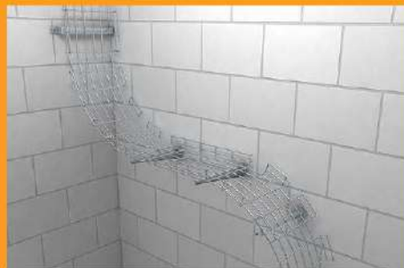
Łuk opadający/wznoszący, użyj nożyc do drutu i gotowe.
