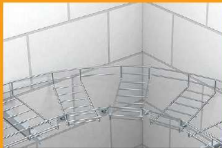
Wykonanie łuku, użyj złączki GEV 36.
