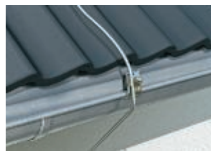
Przewód przymocowany zaciskiem rynnowym
