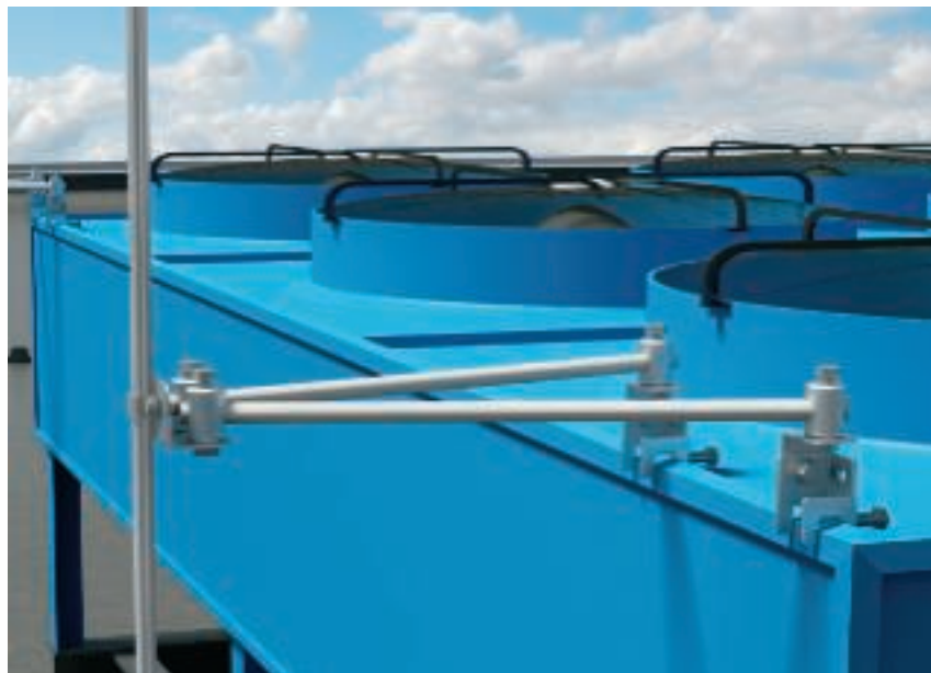
Izolowana ochrona odgromowa z wykorzystaniem uchwytych z włókna szklanego podpiętych do klimatyzatora
